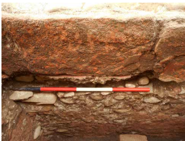
Fig. 19. Scanalatura per l'ammorsamento del pavimento sospeso dell'ambiente I (foto Studio Marco Subbrizio).
