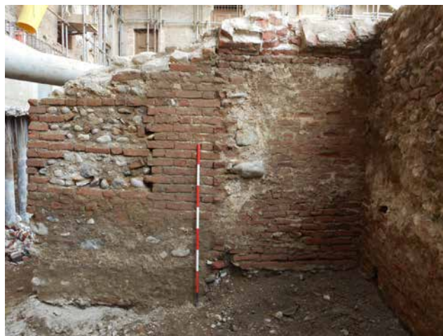
Fig. 50. Fondazione altomedievale in ciottoli inglobata nel muro della cantina (foto Studio Marco Subbrizio).
