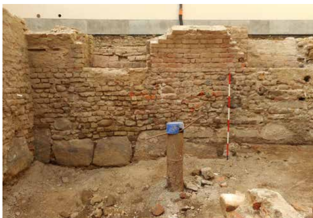
Fig. 55. Basoli romani reimpiegati nel muro della cantina (foto Studio Marco Subbrizio).
