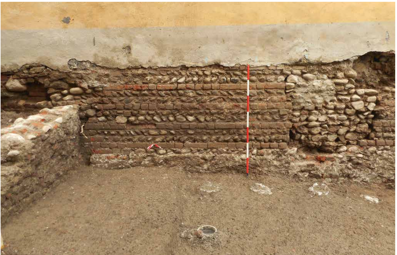
Fig. 64. Struttura muraria bassomedievale con apertura tamponata (foto Studio Marco Subbrizio).
