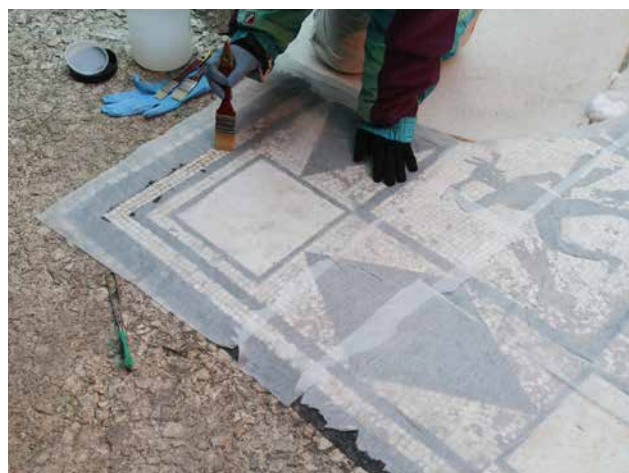
Fig. 77. Applicazione a pennello del prodotto consolidante sulle tessere decoese dello pseudoemblema figurato (foto D. Demonte - F. Di Iorio).
