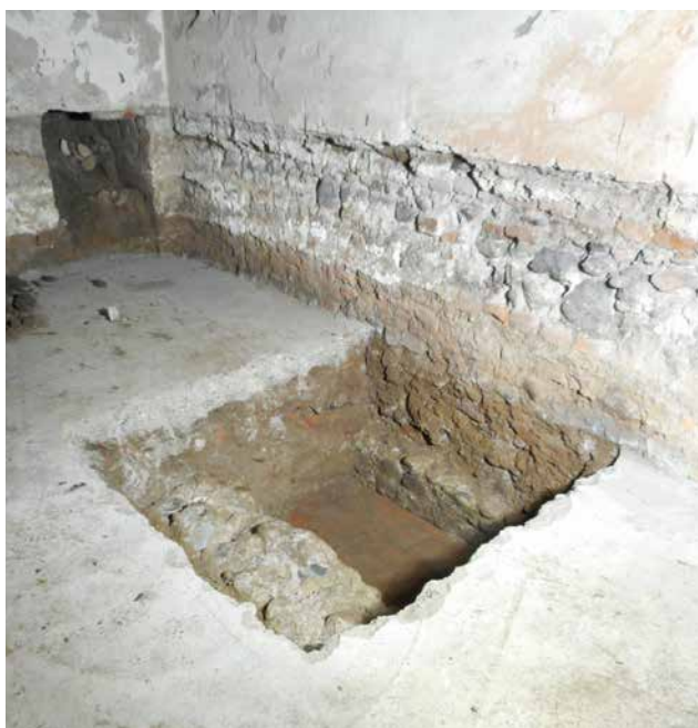
Fig. 3. Condotto fognario individuato nelle cantine dell'angolo nordoccidentale dell'edificio (foto Studio Marco Subbrizio).
