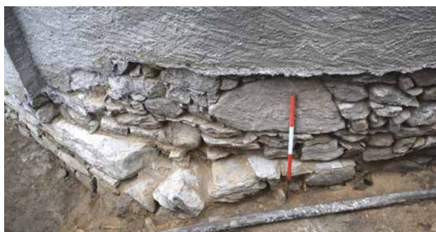
Fig. 41. Valprato Soana, loc. Campiglia Soana. Chiesa di S. Orso. Esterno a nord dell'abside: particolare delle fondazioni di I e II fase, rispettivamente us 117 e us 116 (foto A. Gabutti).
