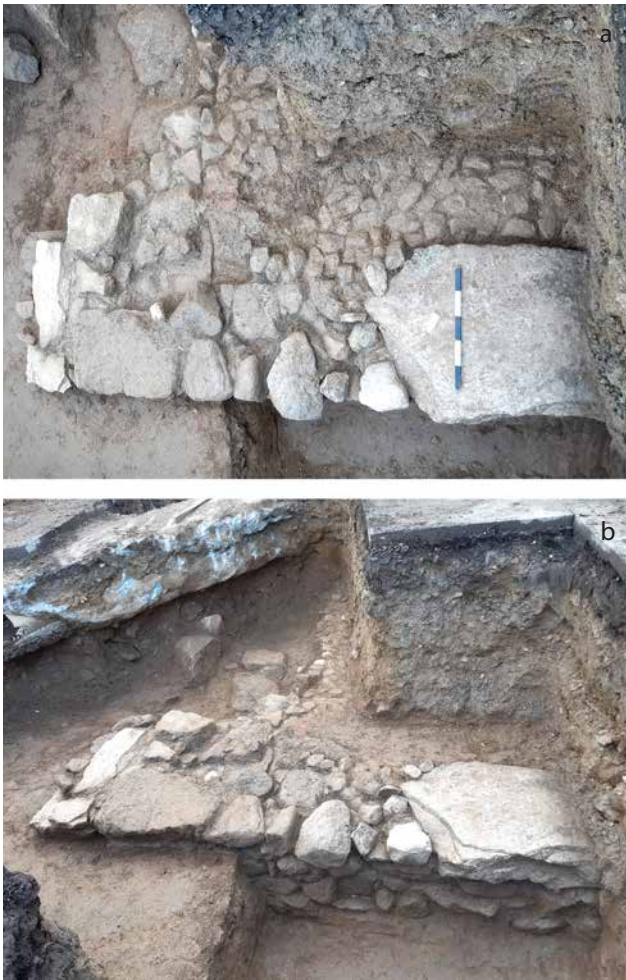
Fig. 35. Vaie. Cappella di S. Lucia. Angolo nord-est della facciata e relativo vespaio (a); particolare della fondazione del perimetrale (b) (foto M. Leonardi).
