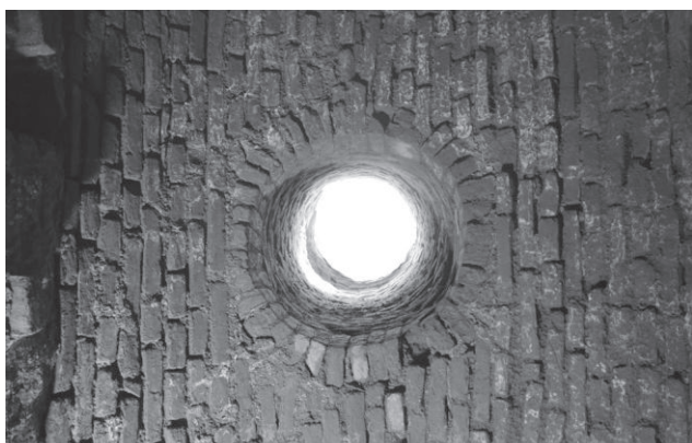
Fig. 16. Pozzo di aerazione visto dall'interno della galleria A (foto GEA S.A.R.T. s.a.s.).
