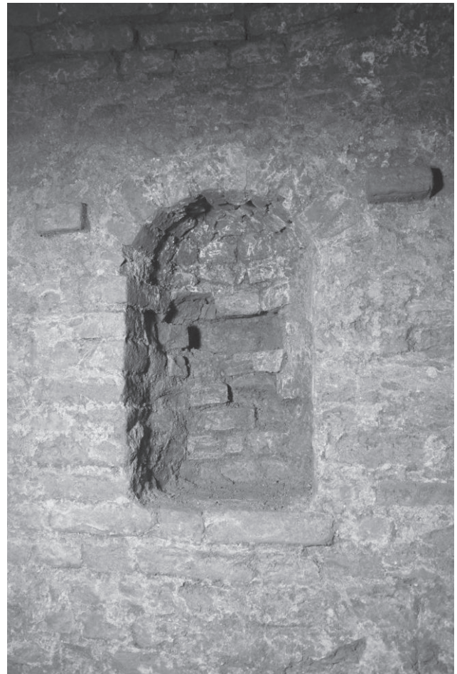
Fig. 14. Nicchia per lampade nella galleria A (foto GEA S.A.R.T. s.a.s.).
