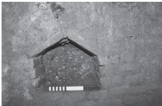
Fig. 21. Nicchia per lampade nella galleria magistrale (foto GEA S.A.R.T. s.a.s.).
