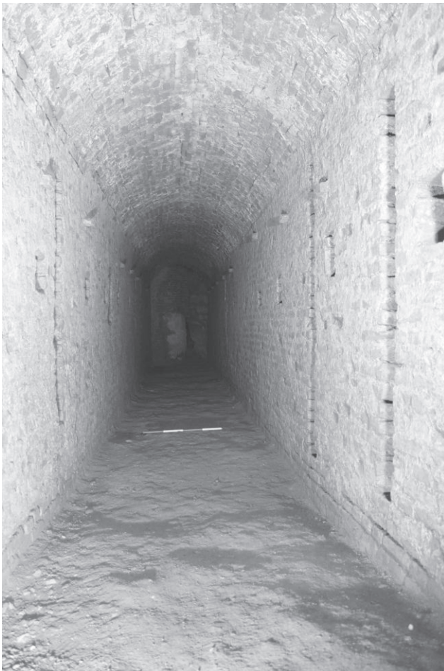
Fig. 13. Interno della galleria A (foto GEA S.A.R.T. s.a.s.).
