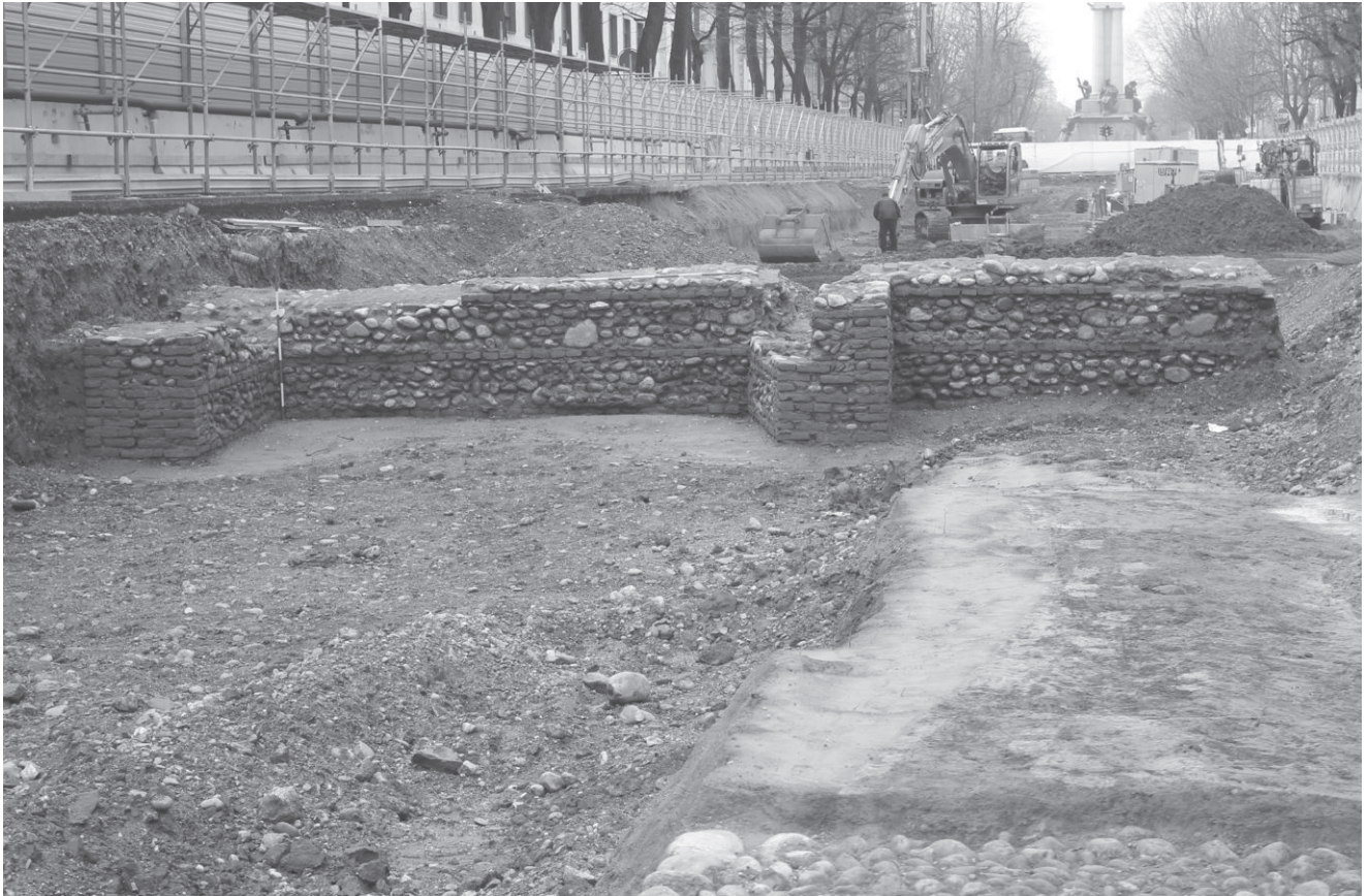
Fig. 1. Panoramica dell'area nel corso dei lavori (foto GEA S.A.R.T. s.a.s.).
