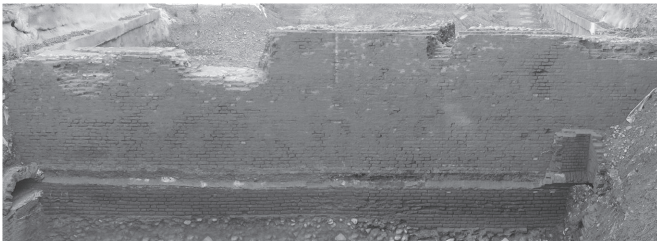
Fig. 9. Fronte meridionale del rivellino, lato esterno (foto GEA S.A.R.T. s.a.s.).
