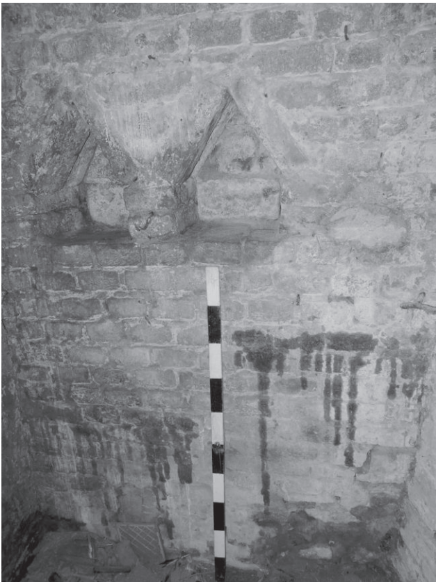
Fig. 4. Coppia di nicchie per lampade, nel vano aperto nel perimetrale nord (foto Studio Marco Subbrizio).
