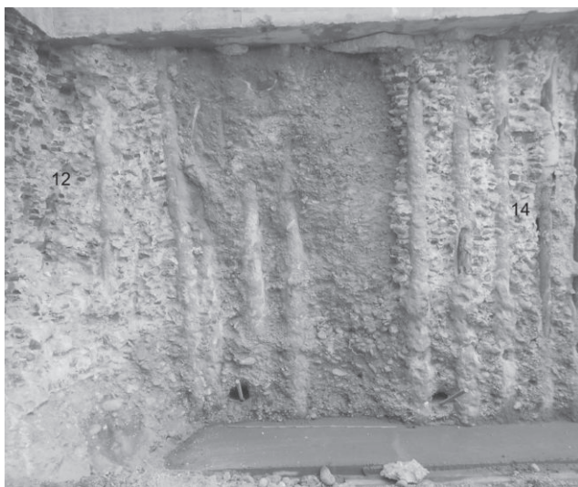
Fig. 12. Sezione del muro us 12 nell'angolo nord-est dell'area di scavo e del contrafforte us 14 (foto O. Cima).
