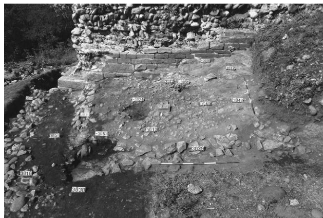
Fig. 137. Gravellona Toce. Castrum Gravallone . Area 3000: panoramica da sud della fase di cantiere dell'edificio A (fase 7) (foto A. Bruna).
