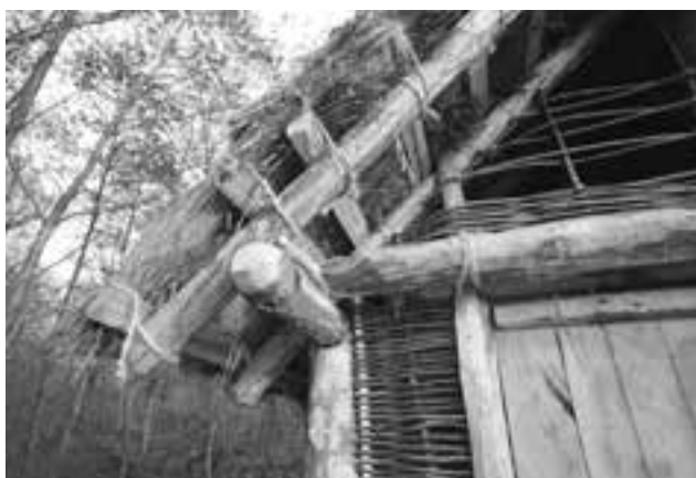
Fig. 88. Montalto Dora. Parco archeologico del Lago Pistono. Particolare della carpenteria del tetto con la copertura in canne palustri (foto Archivio ex Soprintendenza Archeologia del Piemonte).
