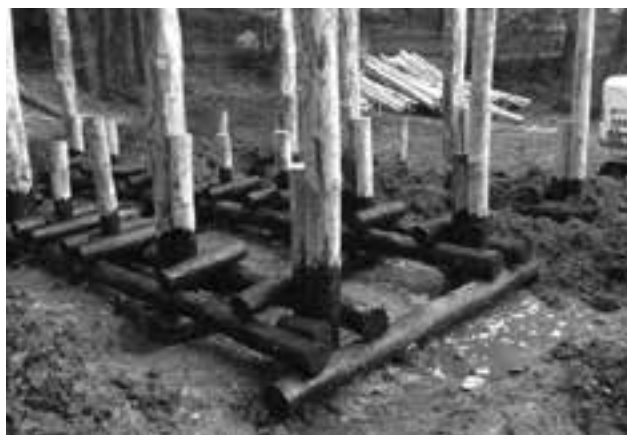
Fig. 87. Montalto Dora. Parco archeologico del Lago Pistono. Le fondazioni della capanna in corso di costruzione (foto Archivio ex Soprintendenza Archeologia del Piemonte).
